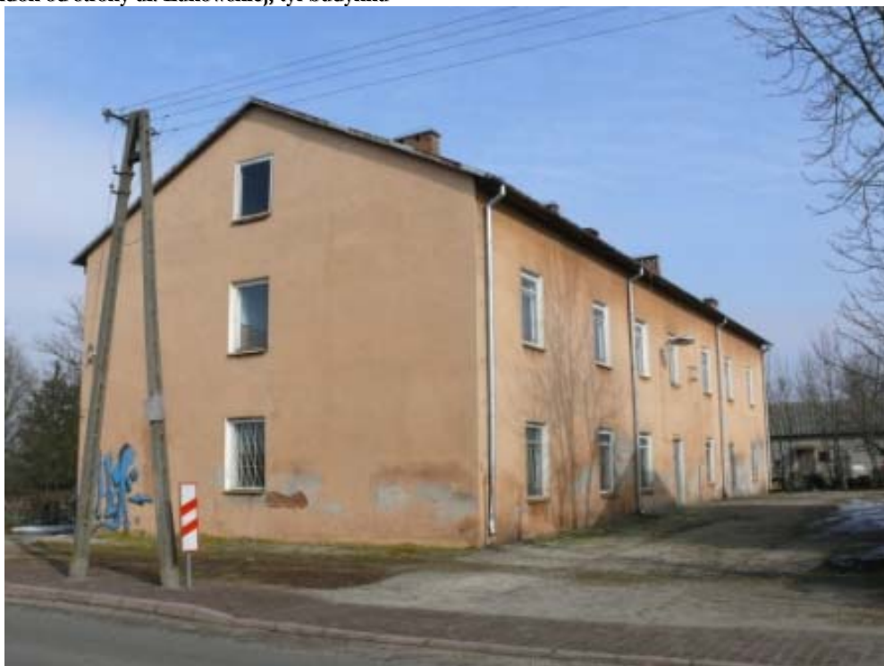
Zdjęcie 3.3 Widok od strony ul. Łukowskiej, tył budynku
