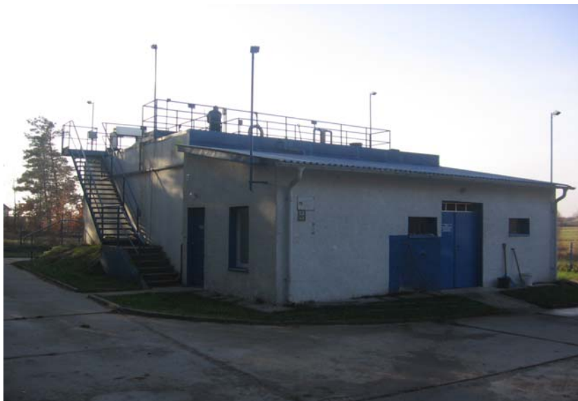
Zdjęcie 3.4 Biologiczno – chemiczna oczyszczalnia ścieków w Krzywdzie
